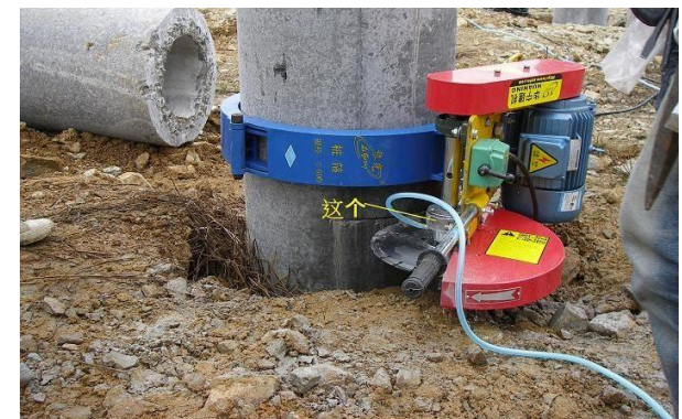
Cắt cọc ép bằng thiết bị chuyên dùng
