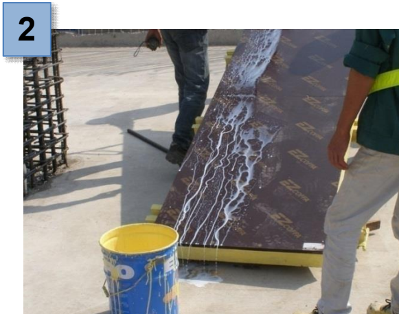
Lăn dầu hỗ trợ tháo ván, dán băng keo chống mất nước
