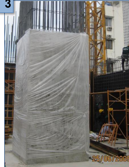
Tháo coffa, bảo dưỡng bê tông cột, đục nhám
