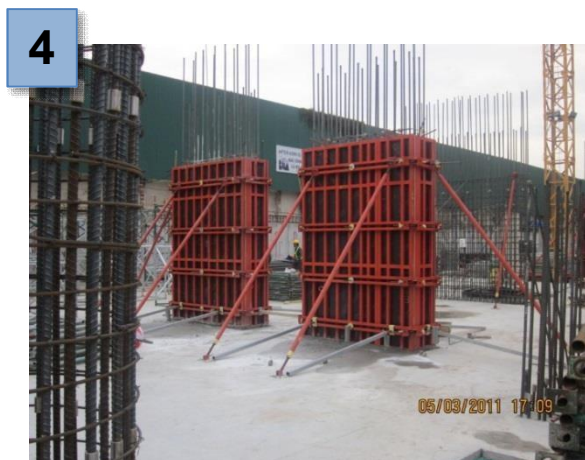
Lắp cây chống
