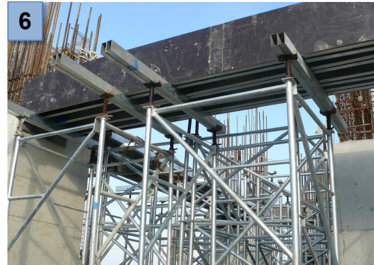
Lắp đáy đà chính và đáy đà phụ
