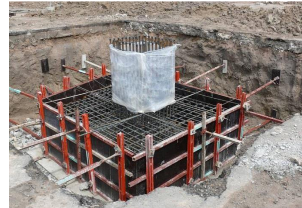
Cây chống thành chống trực tiếp vào đất
