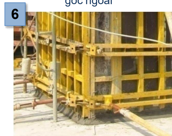
Trám chân để tránh mất nước BT
