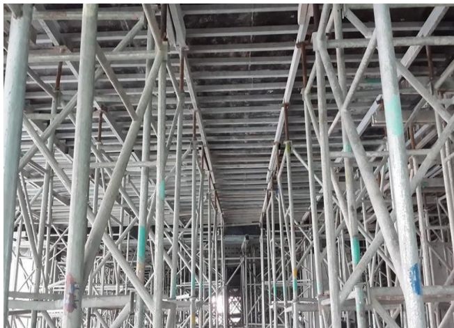
NGHIỆM THU HỆ CỐP PHA CÂY CHỐNG DẦM SÀN
