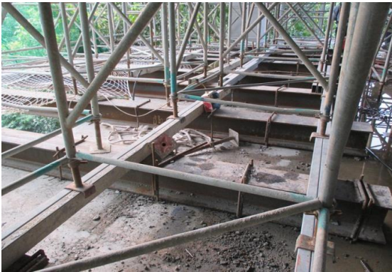
SÀN CONSOLE SỬ DỤNG DẦM H
