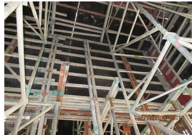
KIỂM TRA CÔNG TY THÀNH DẦM
