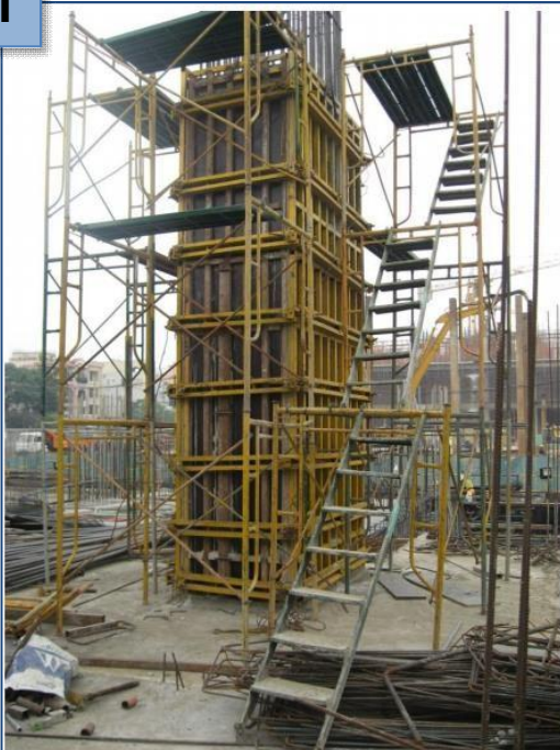
Lắp sàn thao tác thi công bê tông cột
