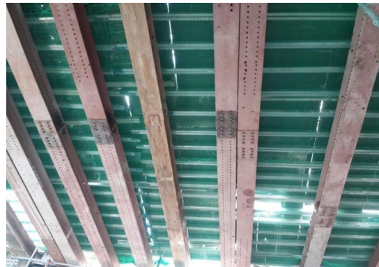
SÀN CAO SỬ DỤNG DẦM H
