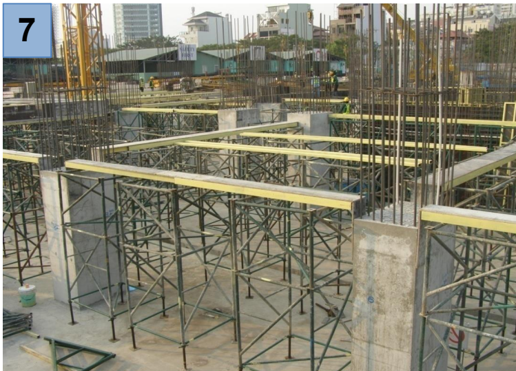
Đóng thành đà và lắp coma sàn
