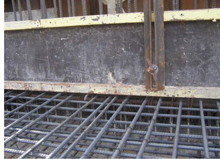
Lắp thành đà treo
